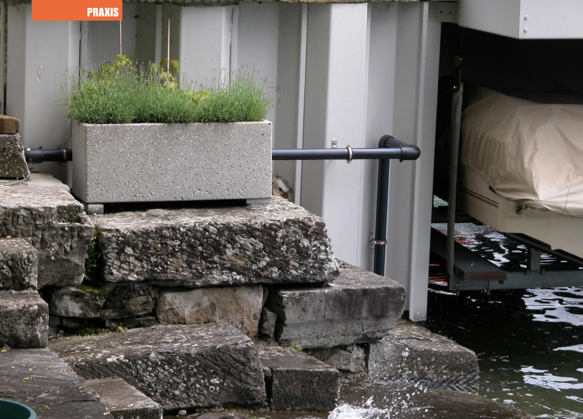
Von hier aus wird das Wasser in den See zurück geleitet. Zu sehen ist Rückgabelleitung vor der Bootshalle
